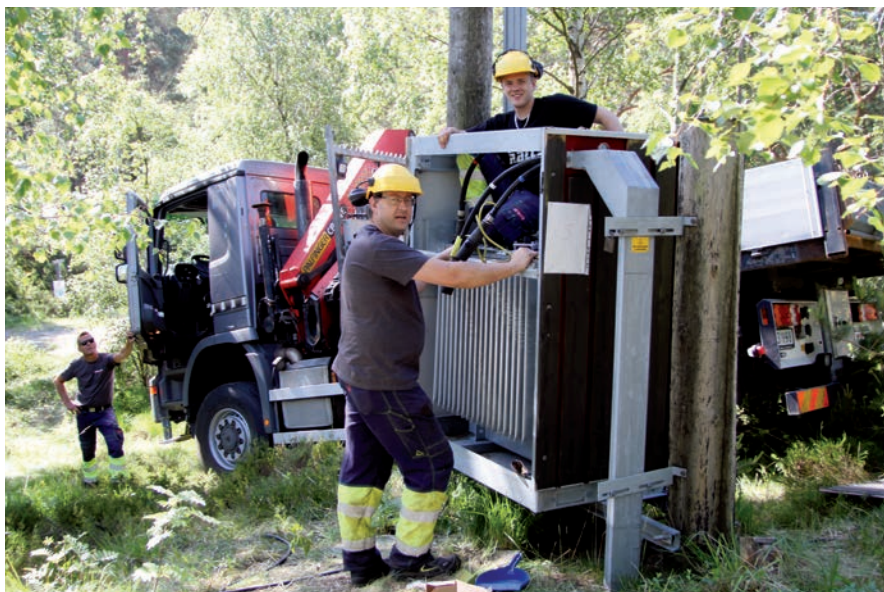
I det vakre turområdet, Vannbassengan i Egersund, må hensyn tas når trafoen skal skiftes. Her med lastebilsjåfør Asle Ueland, montørene Magne Hellen og Jonas Imhof.
